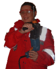
Helferin mit Schutzbrille bei Bohrarbeiten
