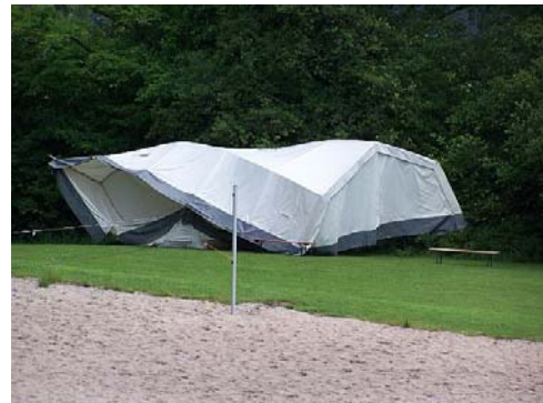
Zelt wurde durch einen einzigen Windstoß diagonal ca. 12 m versetzt und schwer beschädigt. Die beiden Bänke standen ursprünglich in der Längsachse des Zeltes.
